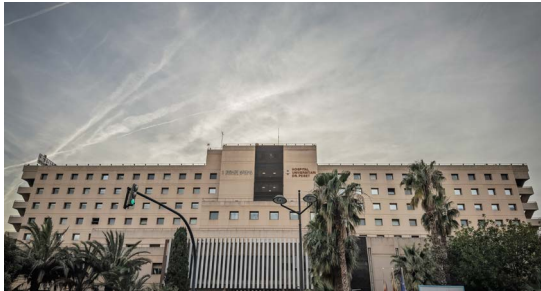
HOSPITAL DR. PESET, Valencia CHILLERS
