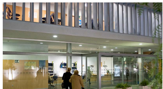
H. R. SOFÍA DE CÓRDOBA Y CTRO DE SALUD Córdoba CHILLERS MODULAR + GMV 6 + BIG-DUCT + U-MATCH
