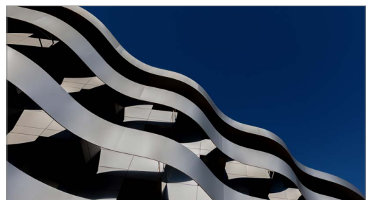
EDIFICIO DE VIVIENDAS, Sant Joan Despí MARINA + U-MATCH CDT
