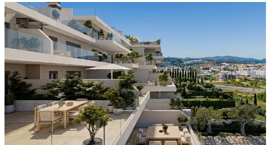
RESIDENCIAS ALTO STANDING ONE Estepona GMV 5 + GMV 6 + U-MATCH CONDUCTO + CENTRALIZADO CE58 MODBUS
